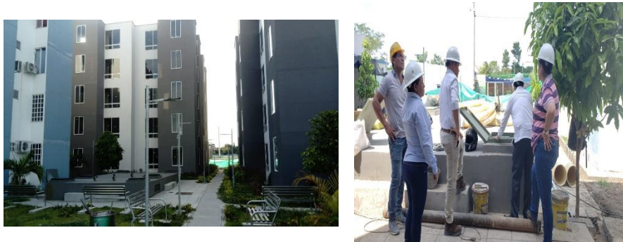
FOTO 2 AVANCE OBRA COLINAS DEL NORTE FASE I
